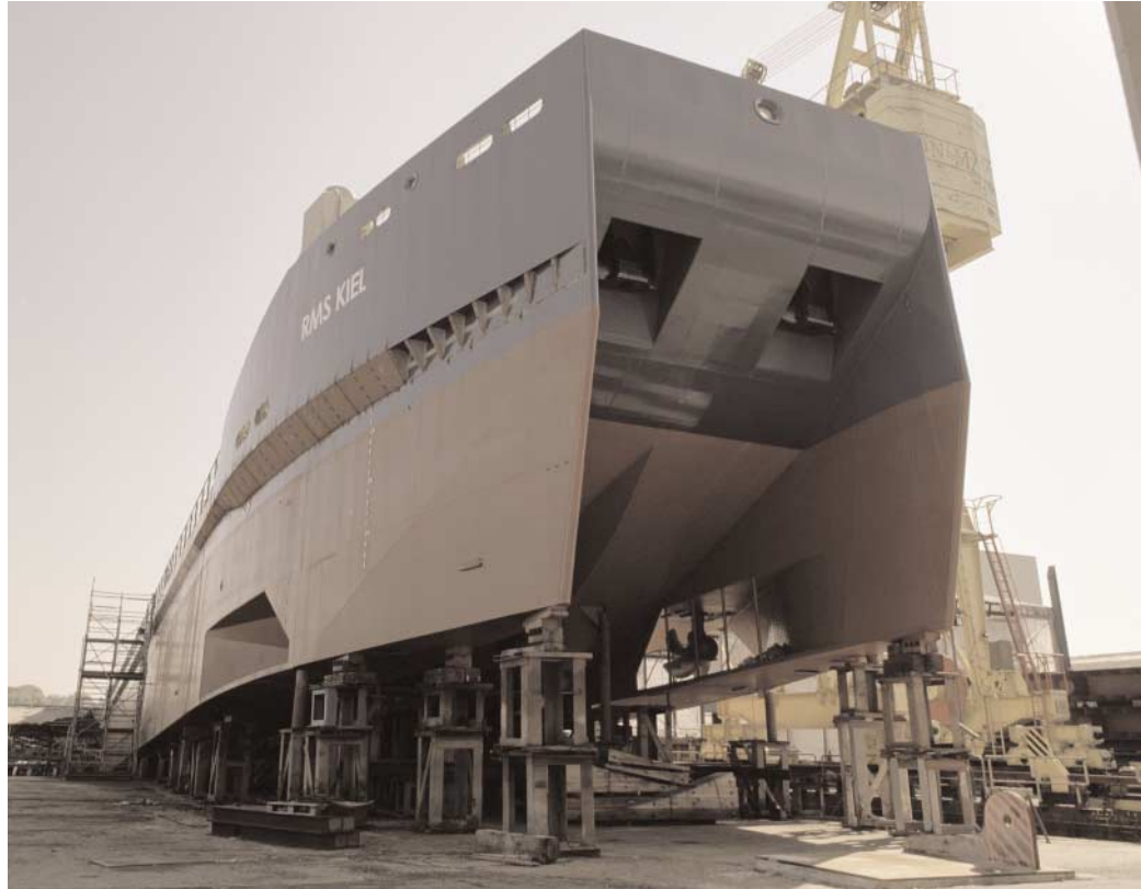
Sparsamer Frachter: Zwei Steven leiten Wasser zu Bugpropellern des Futura Carrier
