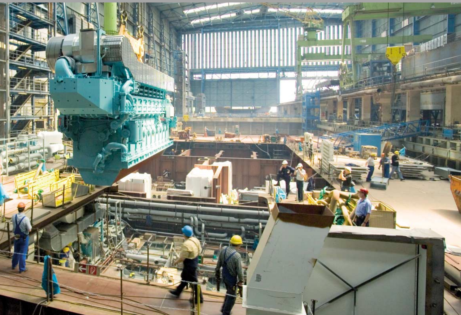
Motor-Montage: Vier 36 000-kW-Diesels werden die in Papenburg gebaute AIDAdiva antreiben und mit Strom versorgen
